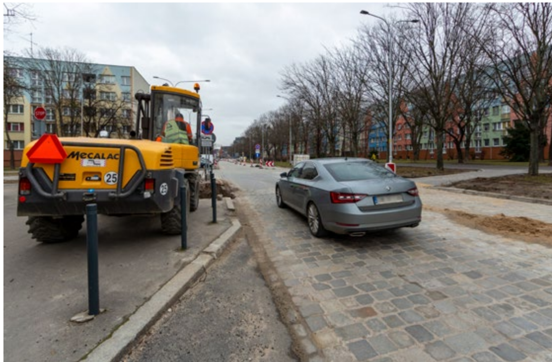
Remont ul. Komandorskiej (na odcinku od Swobodnej do Wielkiej) trwa od października 2021 roku
